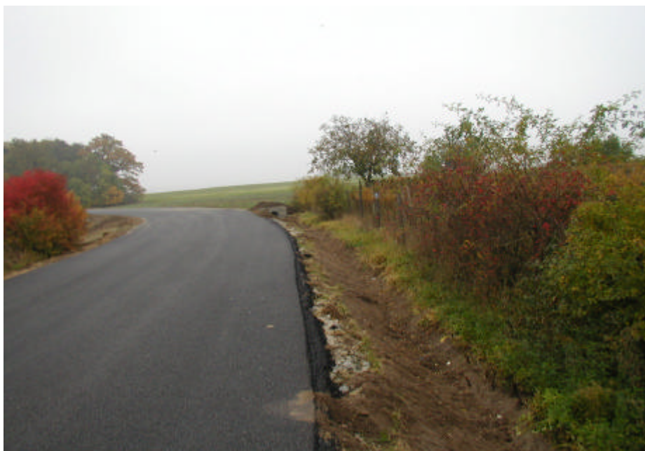
Silnice III/42230 pred dokončením
