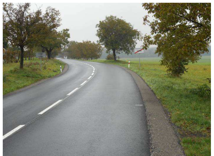
Stav po rekonstrukci
