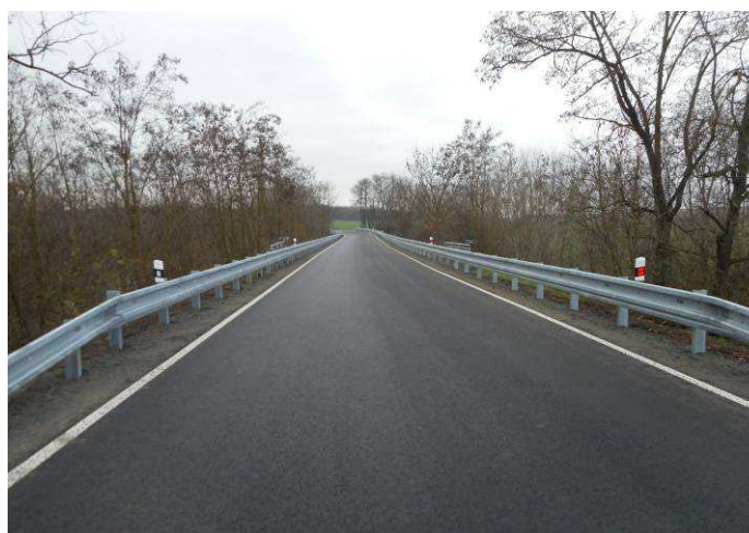
Stav po rekonstrukci
