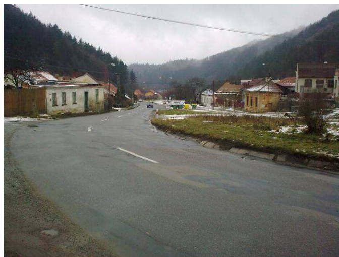
Stav před rekonstrukcí
