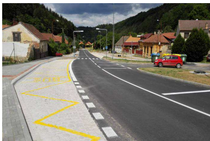
Stav po rekonstrukci
