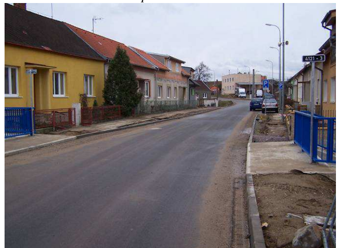
Stav po rekonstrukci
