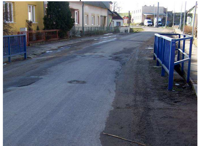
Stav před rekonstrukcí
