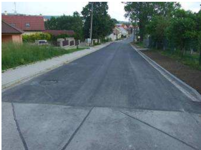
Stav po rekonstrukci
