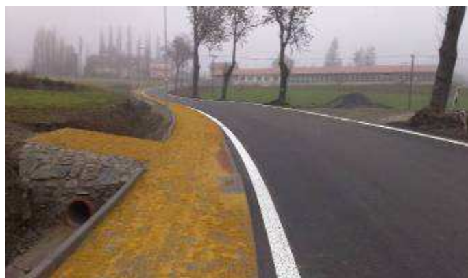
Stav po rekonstrukci
