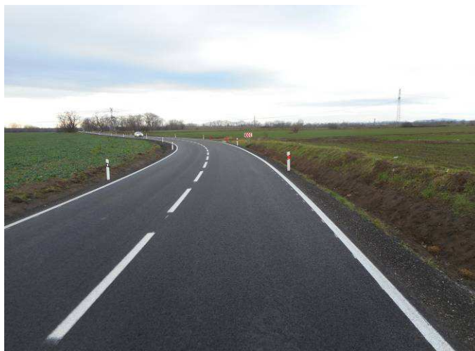
Stav po rekonstrukci
