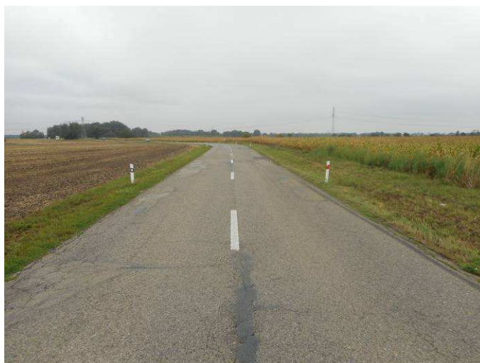
Stav před rekonstrukcí
