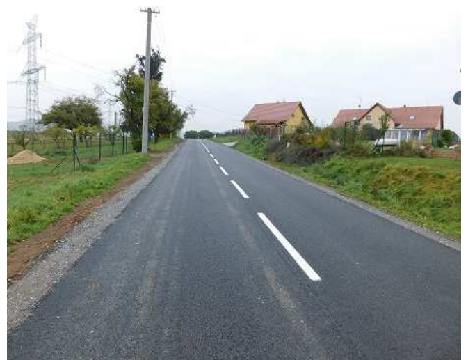
Stav po rekonstrukci
