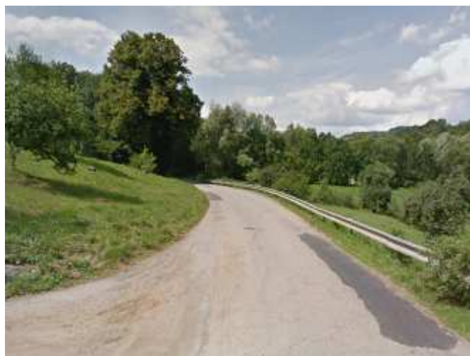
Stav před rekonstrukcí
