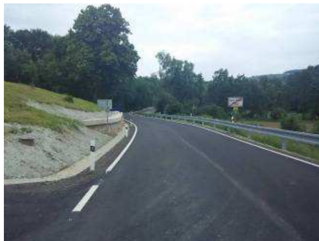
Stav po rekonstrukci
