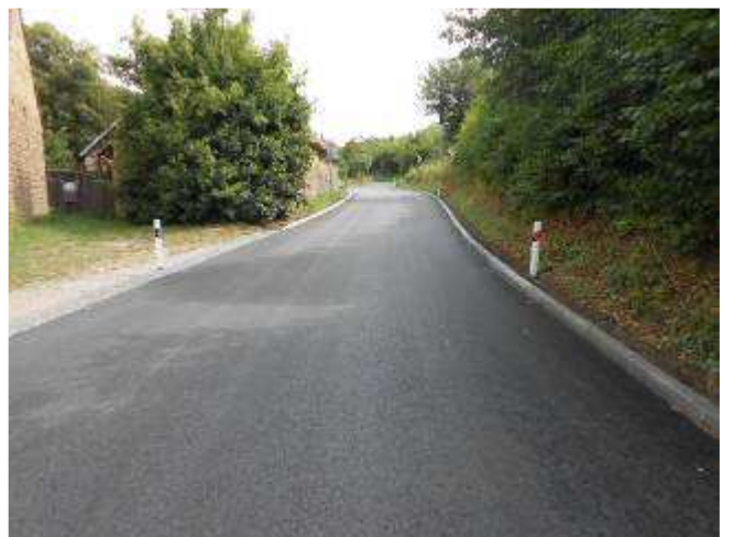
Stav po rekonstrukci
