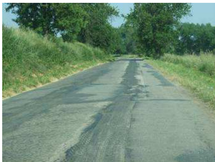
Stav před rekonstrukcí
