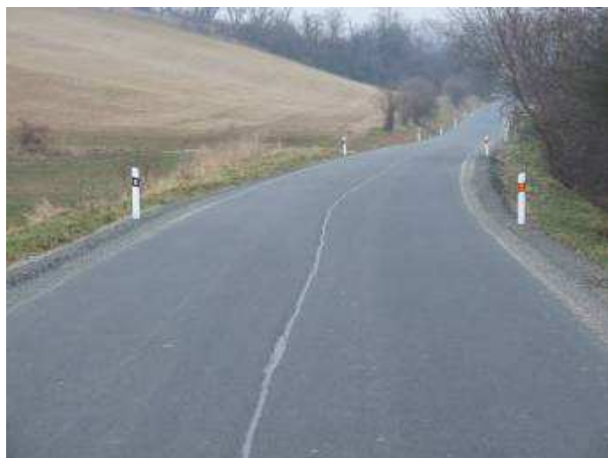
Stav po rekonstrukci
