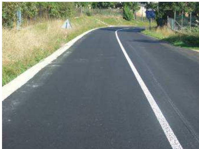
Stav po rekonstrukci
