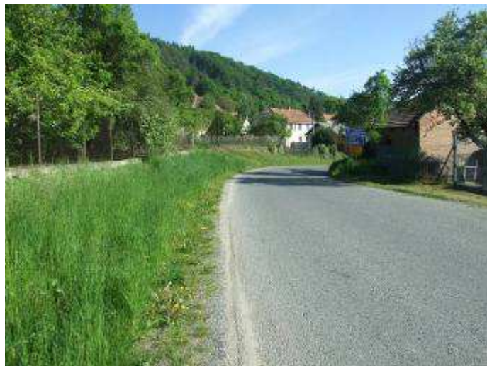
Stav před rekonstrukcí
