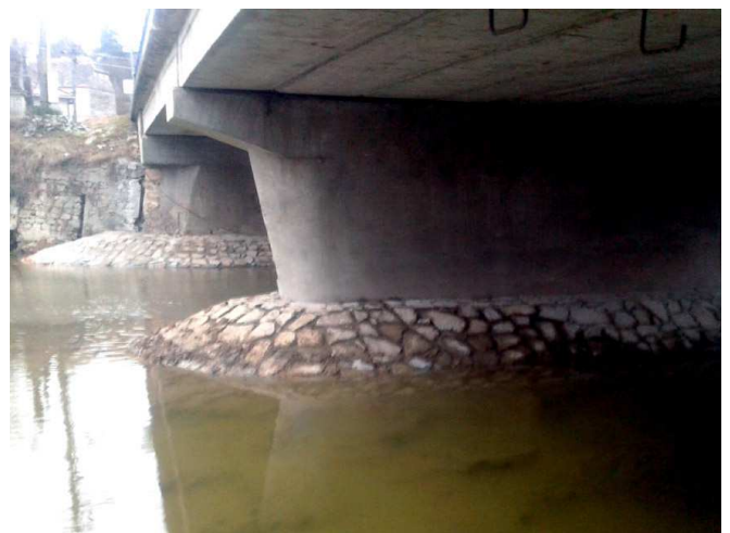
Stav po rekonstrukci
