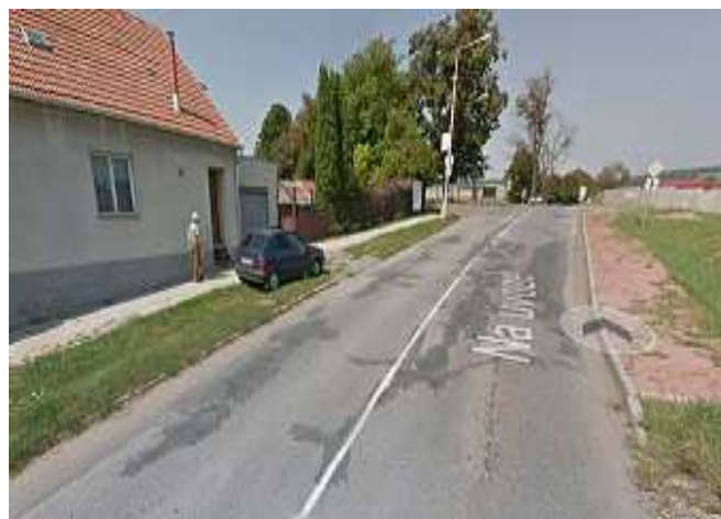
Stav před rekonstrukcí
