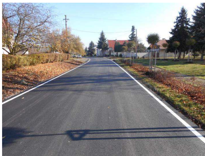
Stav po rekonstrukci
