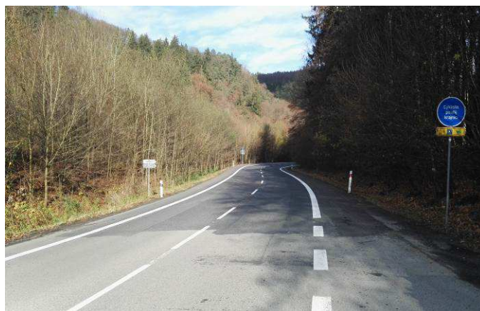
Stav při rekonstrukci
