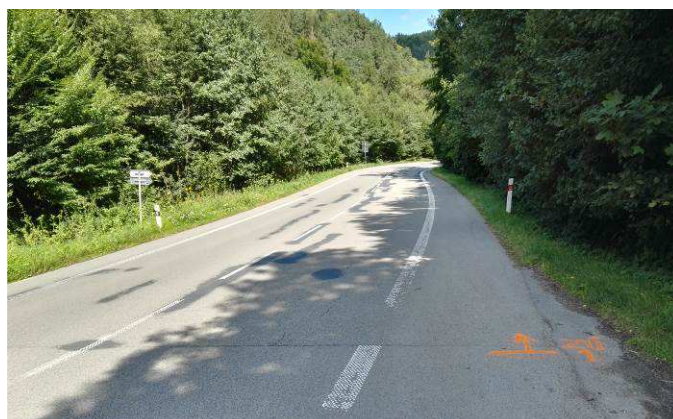
Stav před rekonstrukcí
