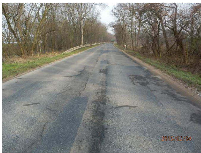
Stav před rekonstrukcí
