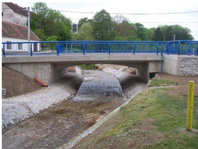
Stav po rekonstrukci
