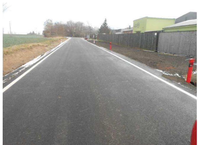
Stav po rekonstrukci
