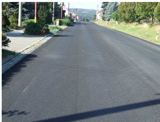
Stav při rekonstrukci
