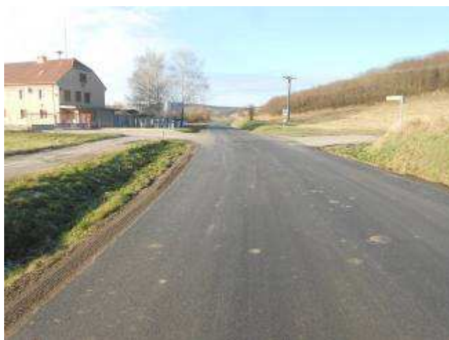
Stav po rekonstrukci
