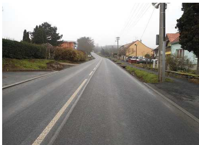
Stav po opravě
