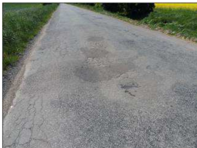
Stav před opravou
