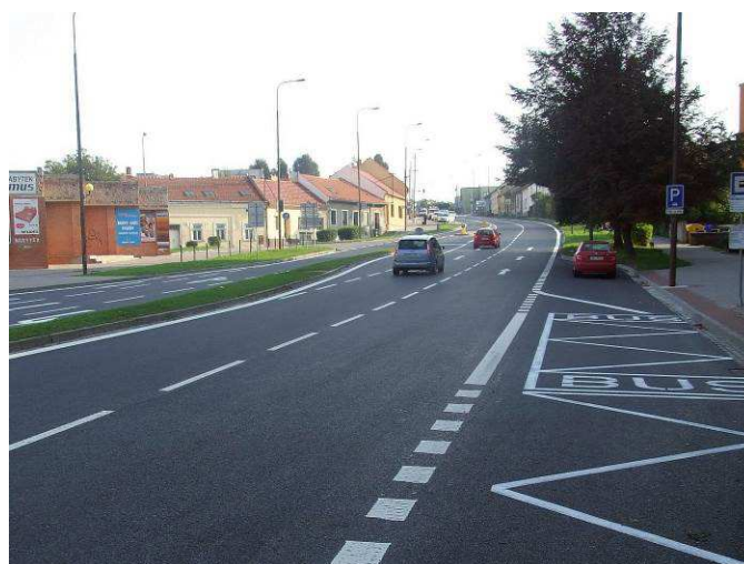
Stav po rekonstrukci
