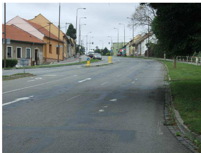
Stav před rekonstrukcí
