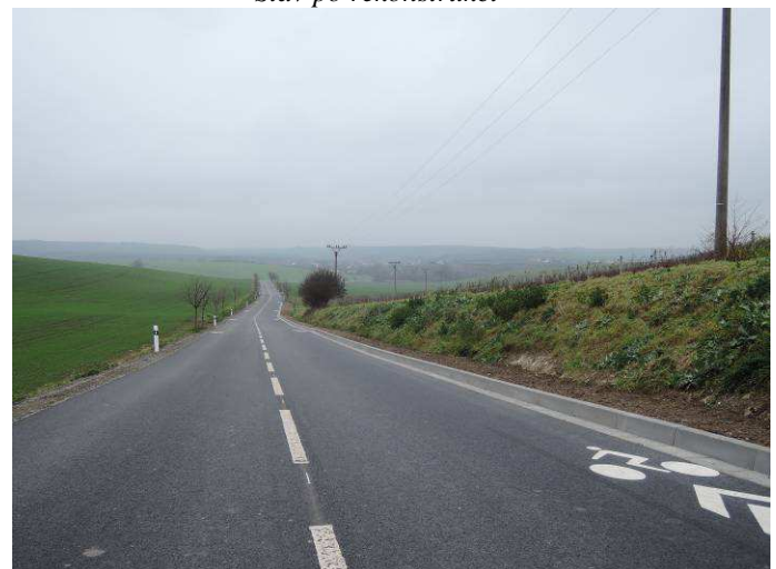
Stav po rekonstrukci
