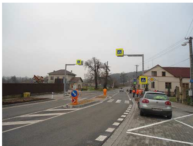
Stav po opravě
