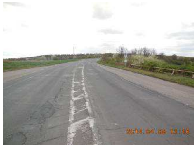
Stav před rekonstrukcí
