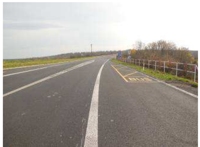
Stav po rekonstrukci
