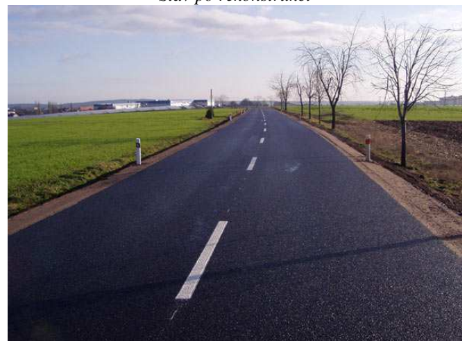
Stav po rekonstrukci
