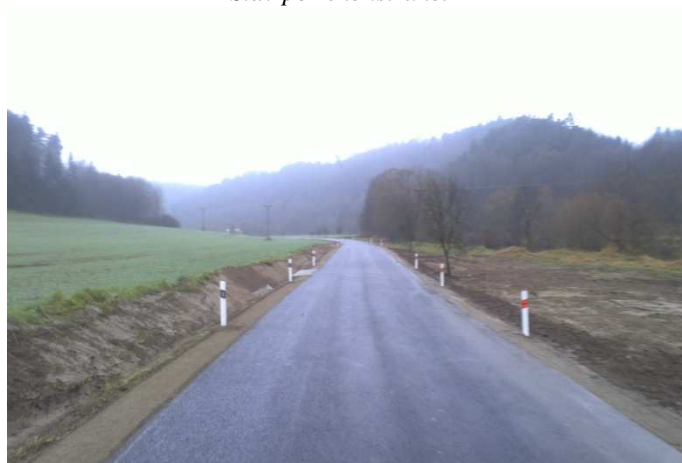
Stav po rekonstrukci
