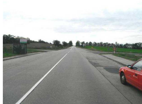
Stav před rekonstrukcí
