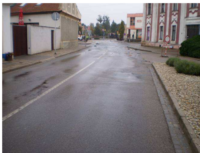
Stav před rekonstrukcí
