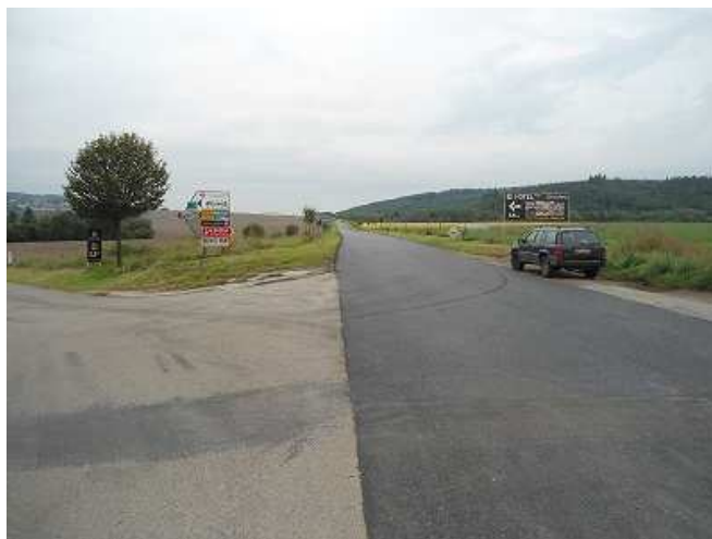
Stav po opravě
