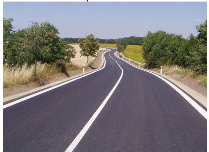
Stav po rekonstrukci
