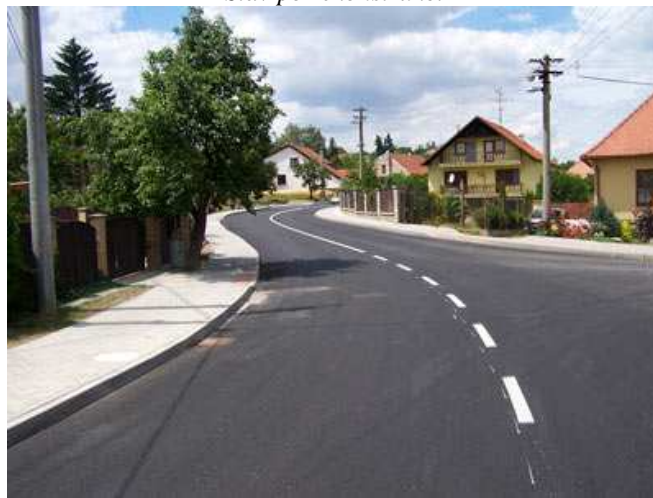
Stav po rekonstrukci
