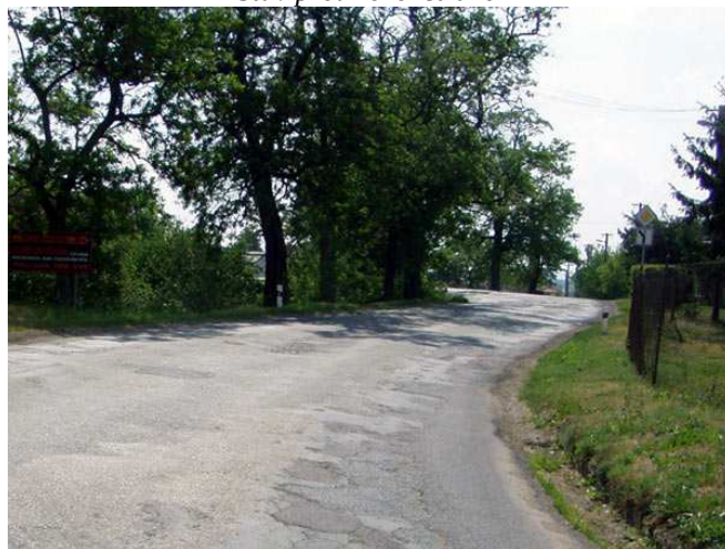
Stav před rekonstrukcí
