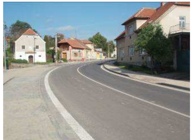
Stav po rekonstrukci
