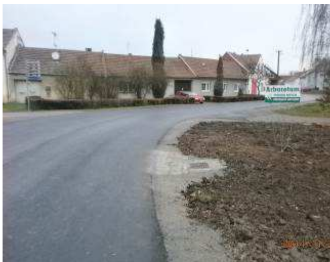
Stav po rekonstrukci
