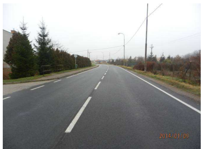
Stav po rekonstrukci
