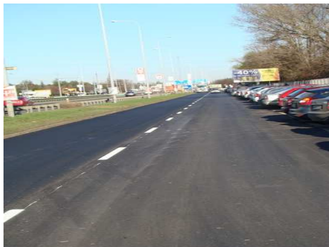
Stav po opravě
