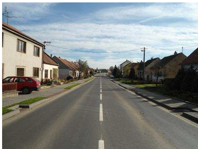
Stav po opravě
