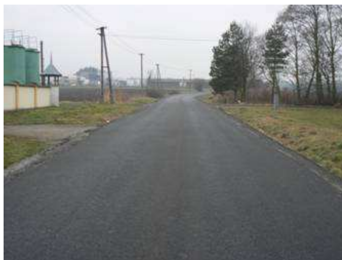
Stav po rekonstrukci
