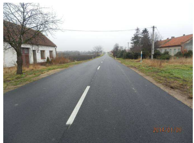
Stav po rekonstrukci
