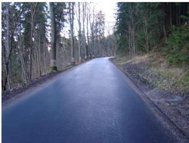
Stav po opravě
