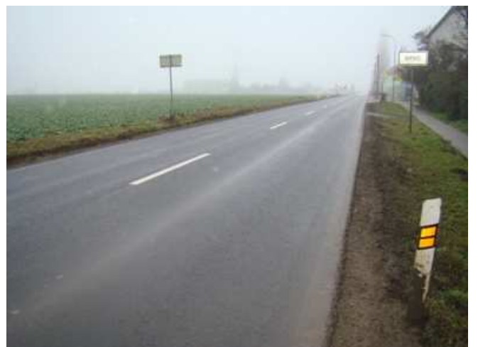
Stav po opravě
