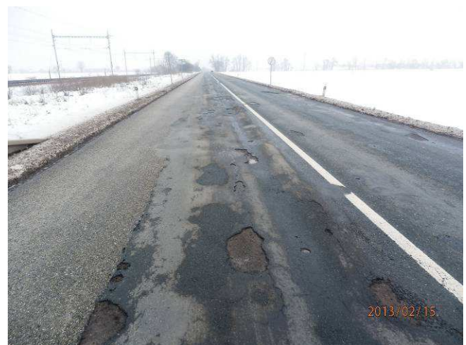
Stav před rekonstrukcí
