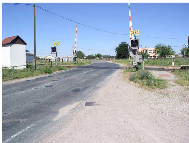
Stav před rekonstrukcí
