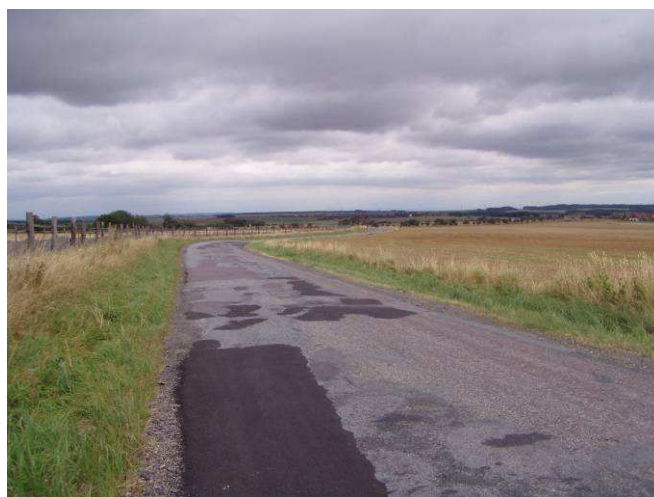
Stav před rekonstrukcí
