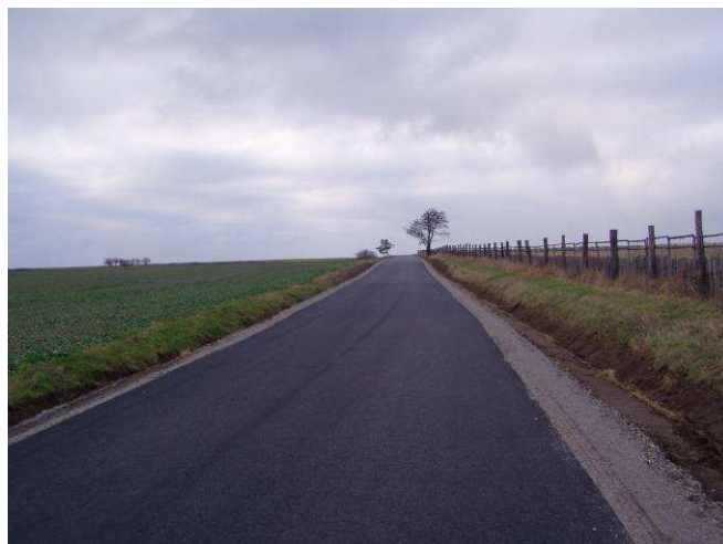
Stav po rekonstrukci
