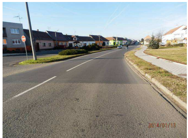
Stav po rekonstrukci
