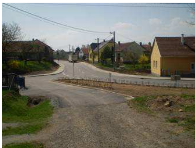
Stav po rekonstrukci
